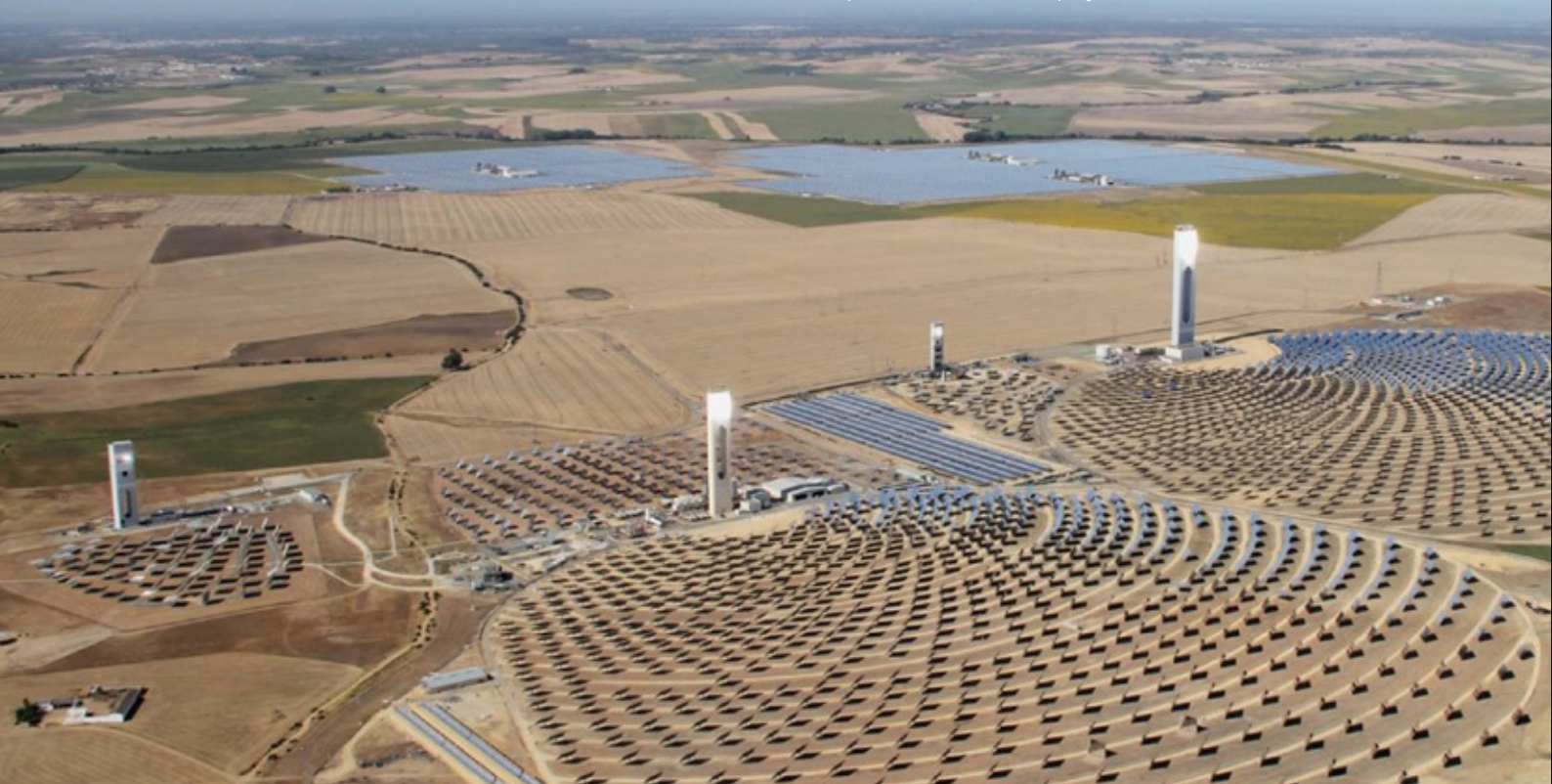
Campo solar de generación proyecto Cerro Dominador. Fuente: Expediente de evaluación proyecto Cerro Dominador.
